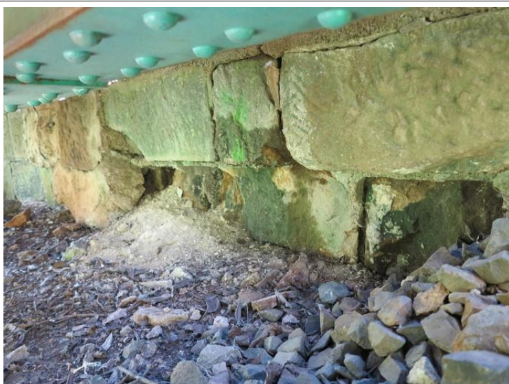
Foto č. 5 O 01 - závěrná zed' degradace kvádrů ve střední části
