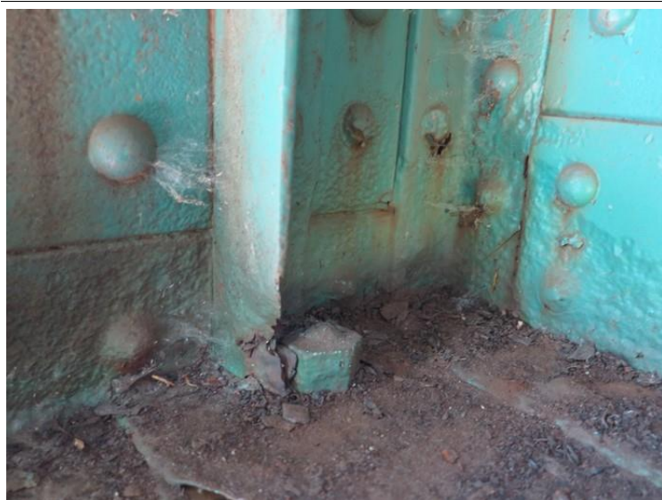
Foto č. 1 K 01 – hlavní nosník vpravo nad O 01, korozní oslabení svislé výztuhy a dolního úhelníku
