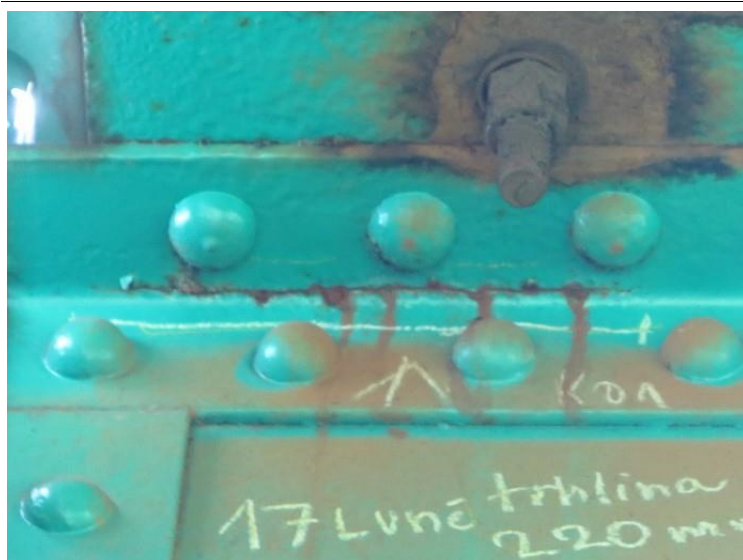
Foto č. 2 K 01 – podélník vlevo, pole 17, vnější část, trhлина v horním úhelníku
