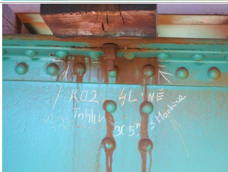
Foto č. 3 K 02 – podélník vlevo, pole 4, vnější část, trhлина v horním úhelníku
