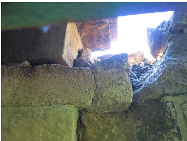
Foto č. 4 O 01 - závěrná zed' vlevo, vypadlé kvádry
